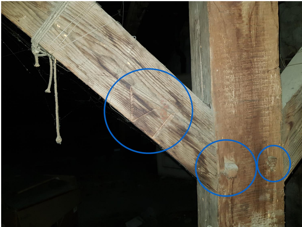
Zdjęcie 35 Połączenie miecza ze słupem oraz znak ciesielski na mieczu, osie 1-6
