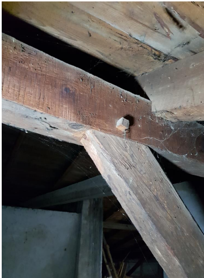
Zdjęcie 36 Połączenie miecza z płatwią, osie 1-6
