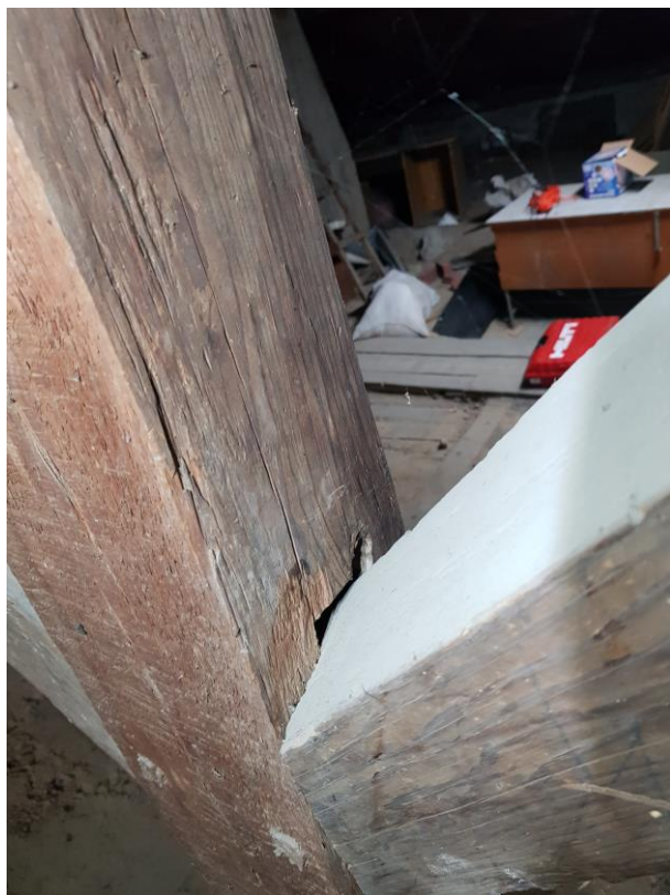
Zdjęcie 30 Czop i gniazdo w połączeniu słup-miecz, osie 1-6
