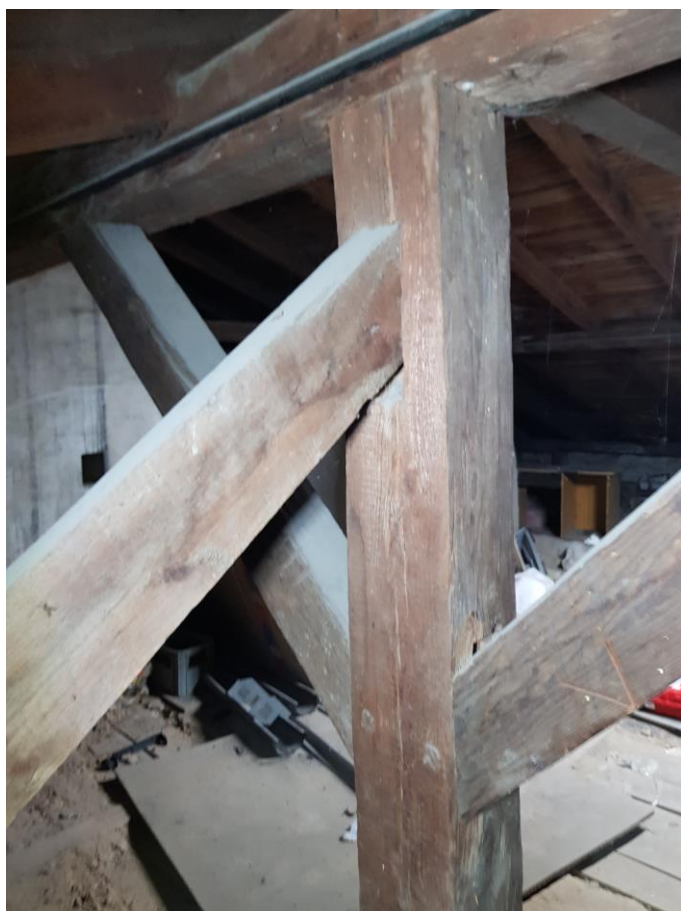
Zdjęcie 29 Połączenie słupa z zastrzałem oraz mieczami, osie 1-6
