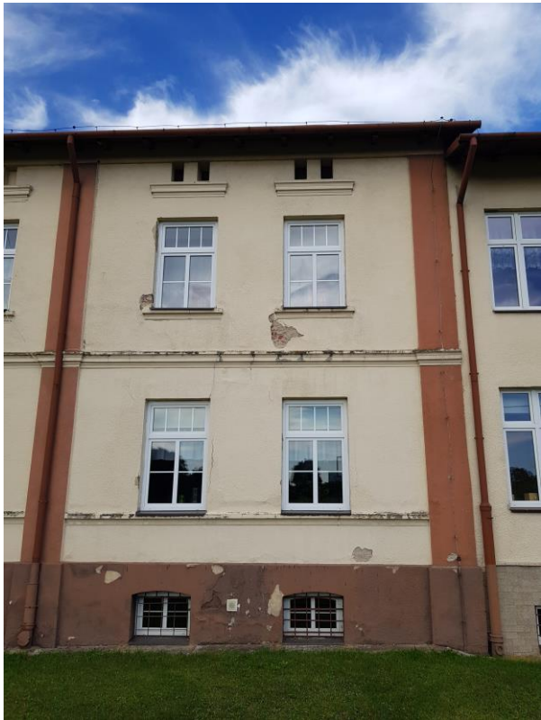
Zdjęcie 14 Uszkodzenia elewacji Zdjęcie 15 Uszkodzenia elewacji
