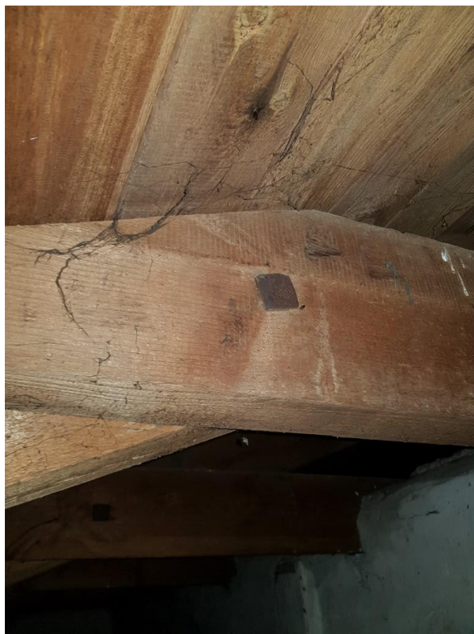
Zdjęcie 47 połączenie skręcane jętki z krokwią, osie 6-8
