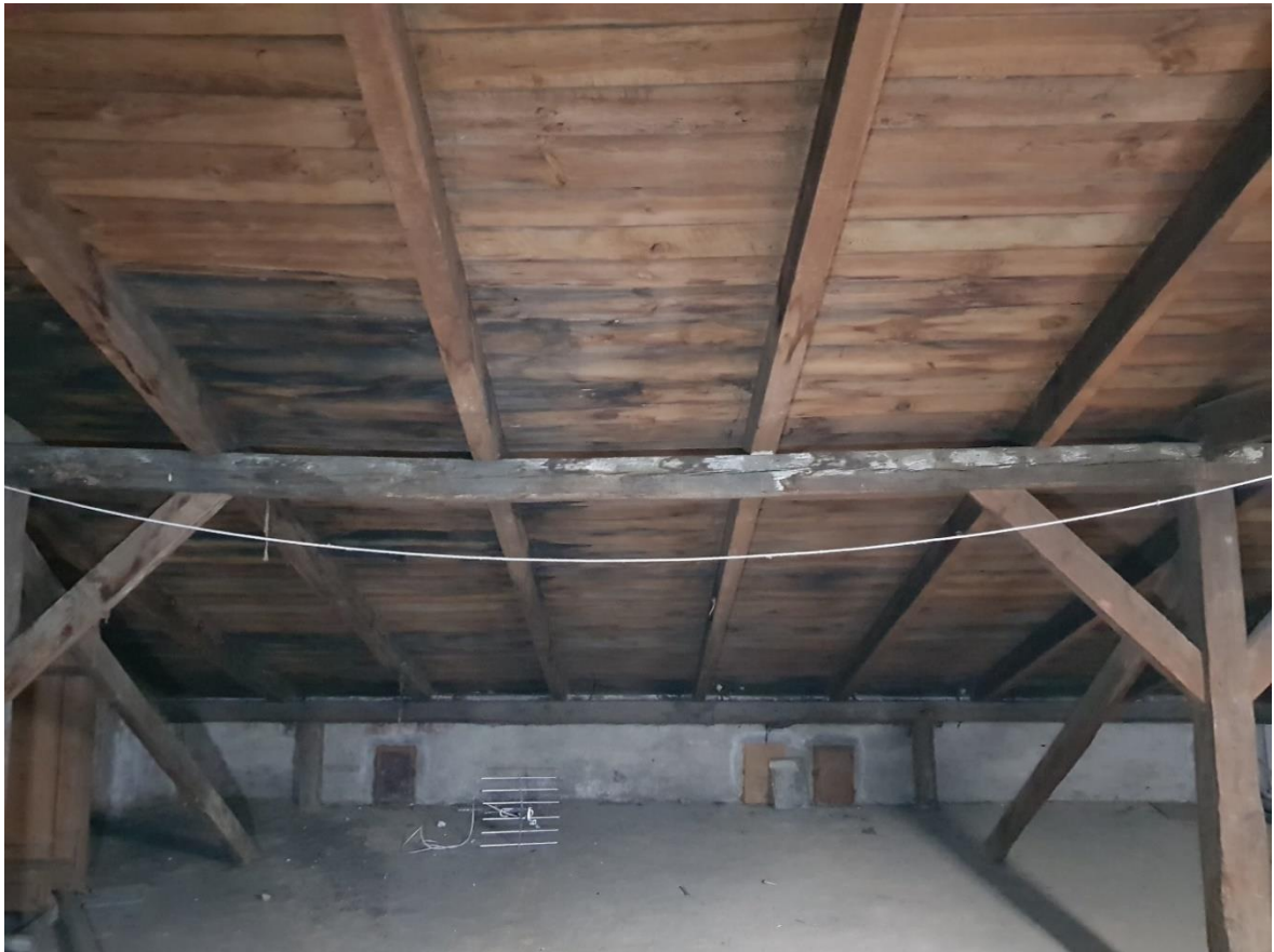
Zdjęcie 21 Nadmierne ugięcia płatwi objętej korozją biologiczną
