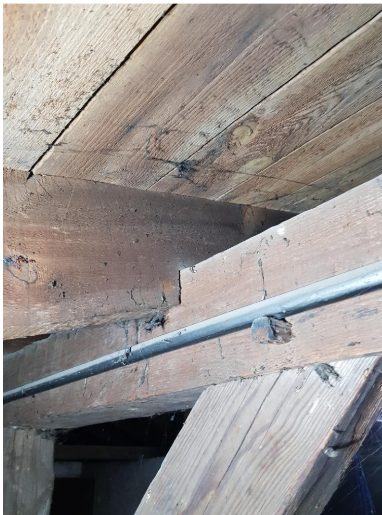
Zdjęcie 26 Oparcie krokiw oraz połączenie miecza z płatwią, osie 1-6
