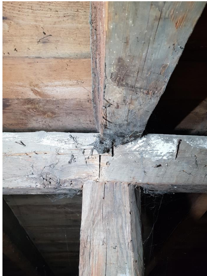
Zdjęcie 25 Połączenie płatwi na nakładkę, osie 1-6
