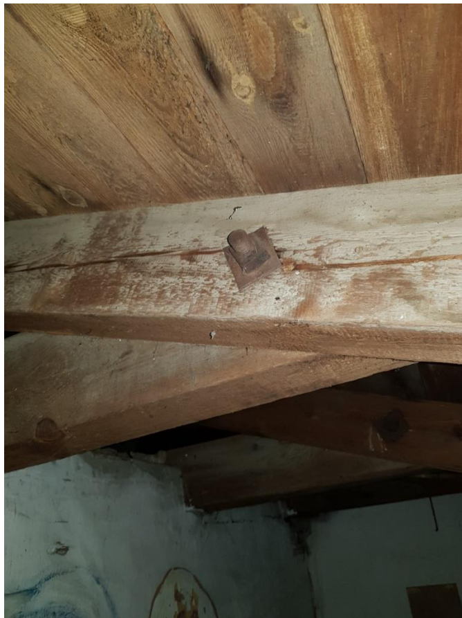
Zdjęcie 46 połączenie skręcane jętki z krokwią, osie 6-8
