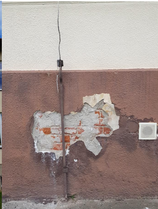
Zdjęcie 14 Uszkodzenia elewacji Zdjęcie 15 Uszkodzenia elewacji
