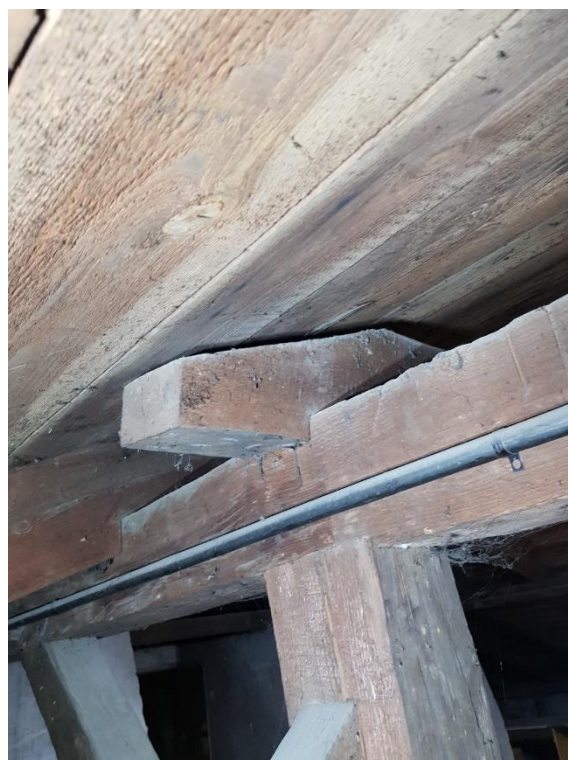
Zdjęcie 27 Połączenie jętki z płatwią, osie 1-6
