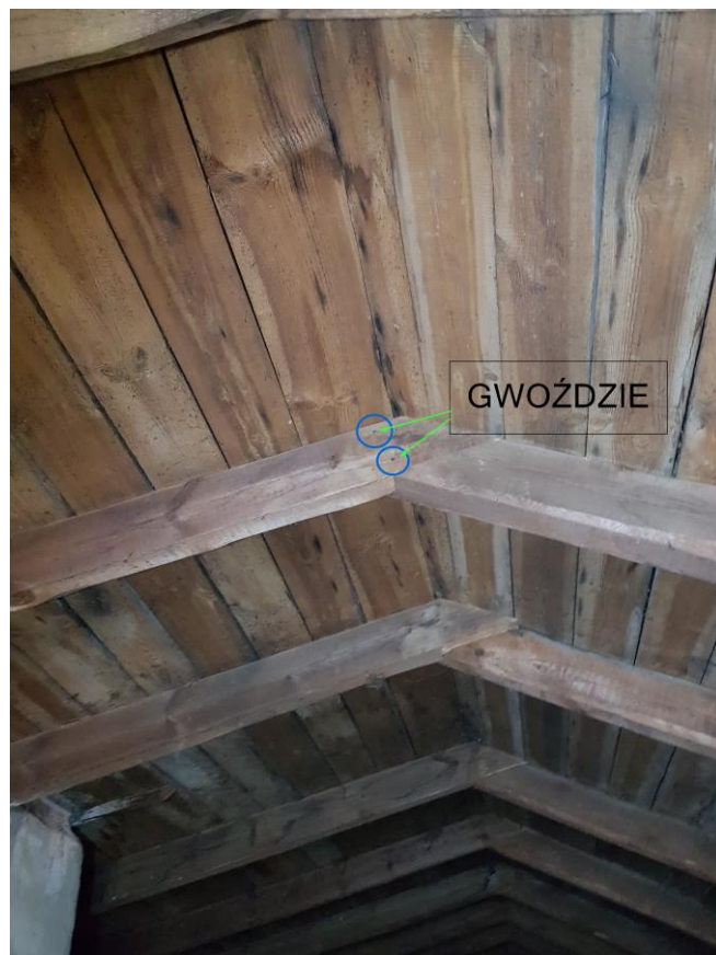
Zdjęcie 28 Połączenie krokwi na nakładkę, osie 1-6
