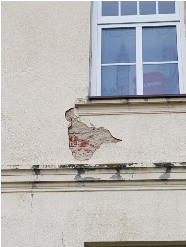
Zdjęcie 16 Uszkodzenia elewacji Zdjęcie 17 Uszkodzenia elewacji
